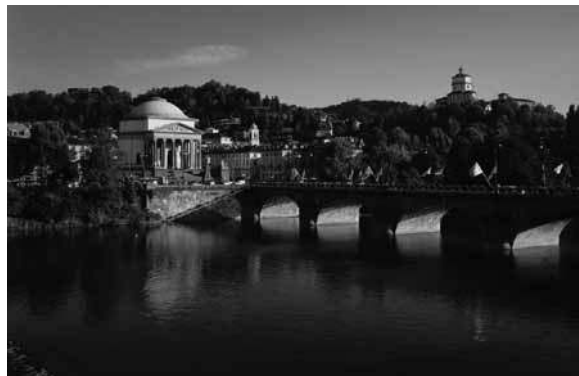
Turin, Chiesa Gran Madre di Dio, 1818-1831, mit Brücke über den Po, Foto: Uwe Rüdénburg, 2000
